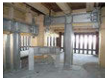
木造の五重塔の耐震補強
