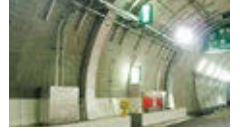
消火設備取り付け金具
